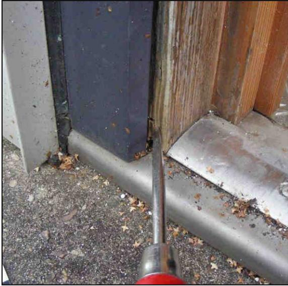
**Abb. 2.3.5-4:** Feuchtigkeitsschäden an den Rahmenstielen der Tür
