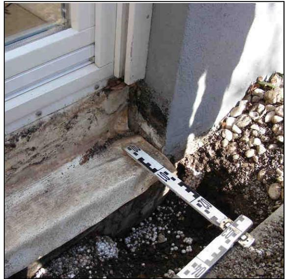
**Abb. 2.3.3-5:** Unzureichende Abdichtungsmaßnahmen am Türanschluss
