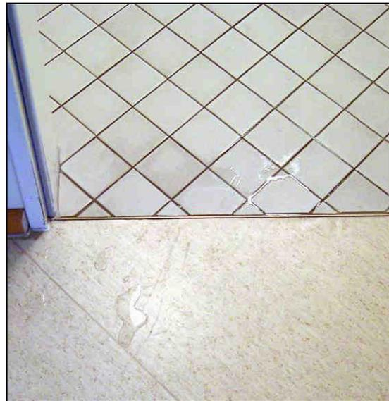
**Abb. 3.5.1-2:** Feuchtigkeitsbeanspruchung der Schwelle
