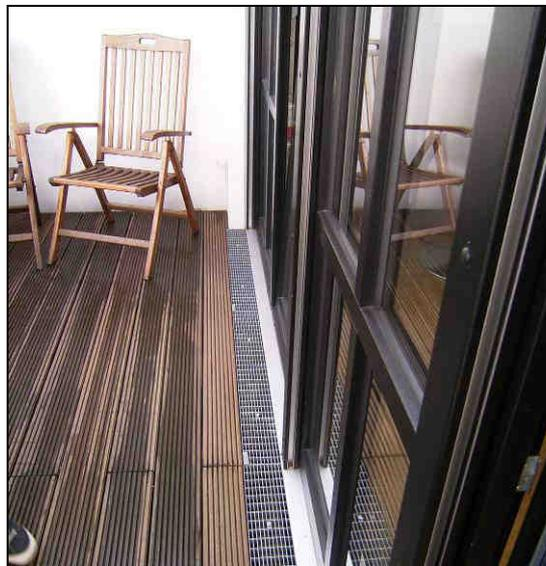
**Abb. 2.5.3-2:** Anschluss Balkon
