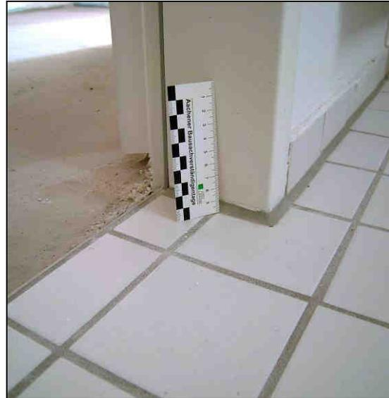
**Abb. 3.5.3-2:** Übergang Bad/ Flur, im Flur ist noch keine Nuttschicht verlegt**Begehung:** 09/ 2008
