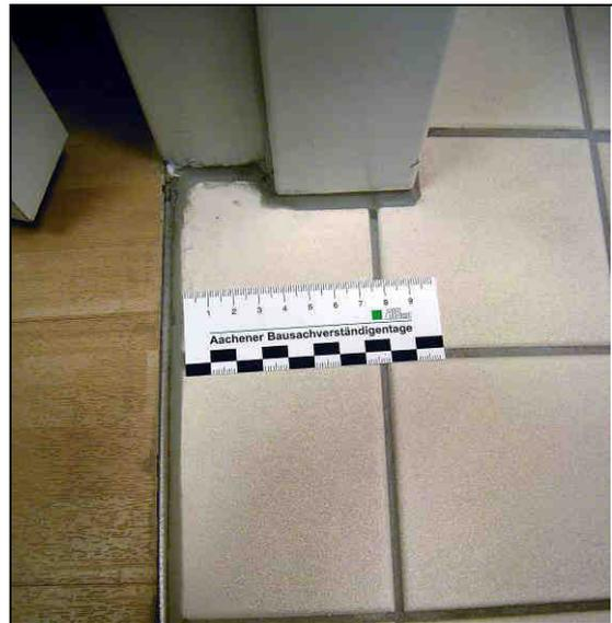
**Abb. 3.3.1-2:** Leichte Durchfeuchtungsschäden am anschließenden Parkettboden
