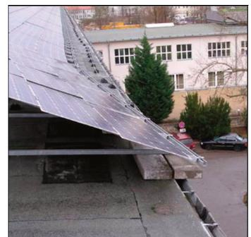
Als vierte Gruppe sind unzureichende Sicherungen gegen Horizontalverschiebung bei ballastoptimierten Anlagen zu nennen. Der Trend zu immer leichteren Anlagen, deren Ballastierung aufgrund von aerodynamischen Studien minimiert werden kann, erhöht aufgrund der größeren Modulfelder die Gefahr von sogenannten „Temperaturwanderungen“. Da die Haftreibungseigenschaften zwischen Dach-
